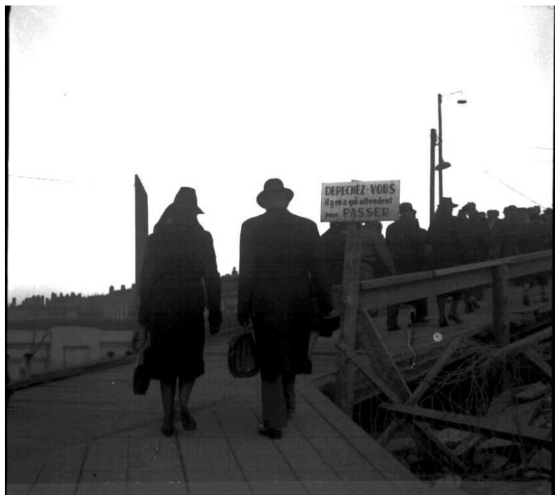
Document 1 Photo Charles Bobenrieth-Collection Nouvellet-Dugelay Cette passerelle a été installée sur l'un des ponts de Lyon détruits par les Allemands. Il est inscrit sur le panneau : Dépêchez-vous, il y en a qui attendent pour passer.
